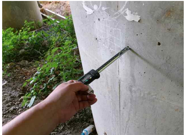
탄산화깊이 측정 현황
